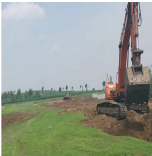
保安村集中储粮点施工现场
