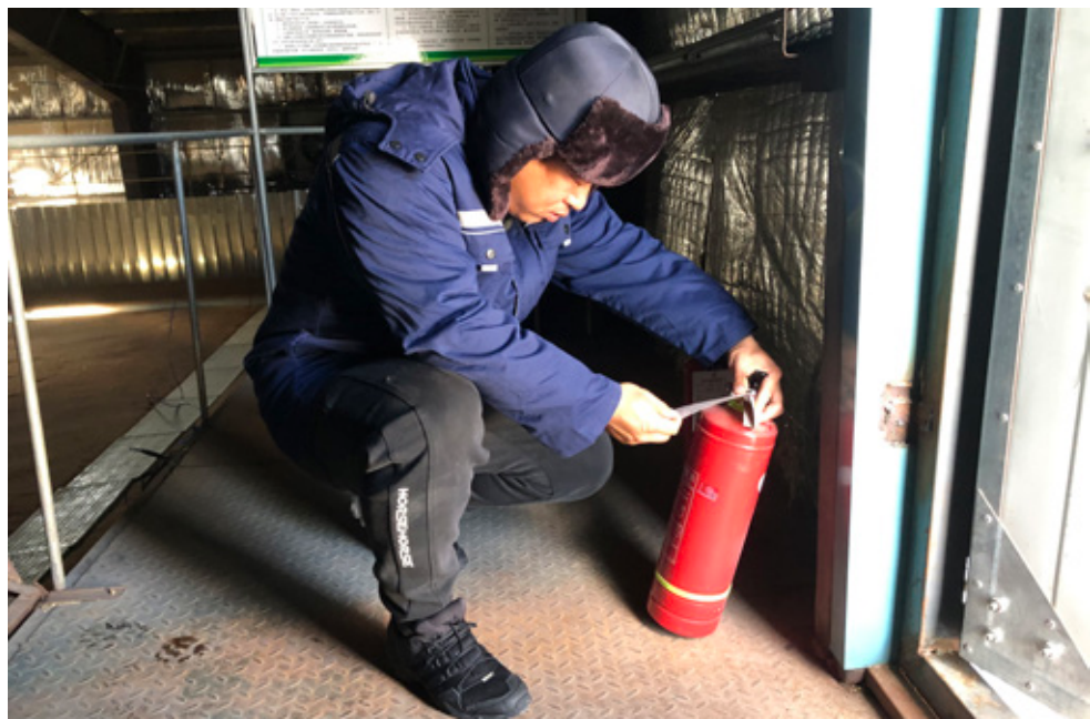
虎林市新虎林粮库有限公司高峰正在检查灭火器
