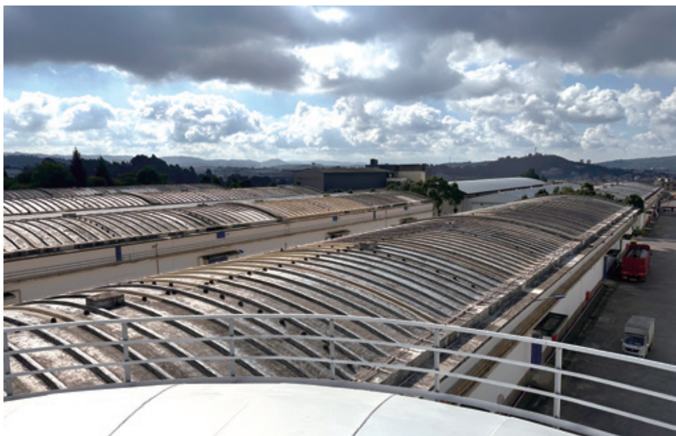
未架顶的拱顶仓在烈日的炙烤下翻滚着热浪
