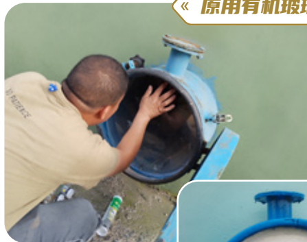
1 原用有机玻璃0.3公分厚密闭风道口
