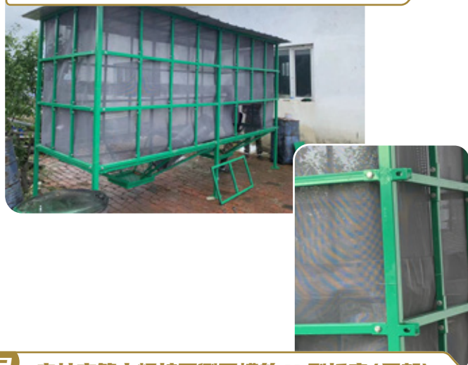
3 立柱方管上焊接两侧开槽的 U 型托座（局部）
