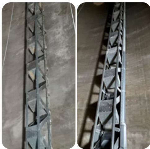
» 浅圆仓溜槽径向通风改造前后对比图 2 «
