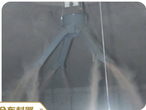
1 浅圆仓“器”字型防破碎无动力匀料入仓布料器 »
