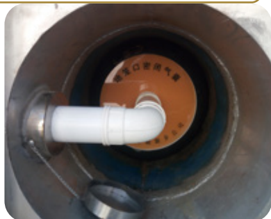
2 地笼口密闭隔热气囊使用图 »
