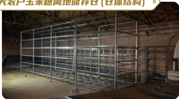
2 大农户玉米穗离地储存仓 (仓体结构) »
