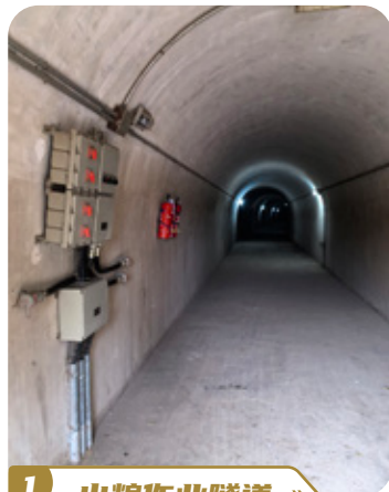
1 出粮作业隧道 »
