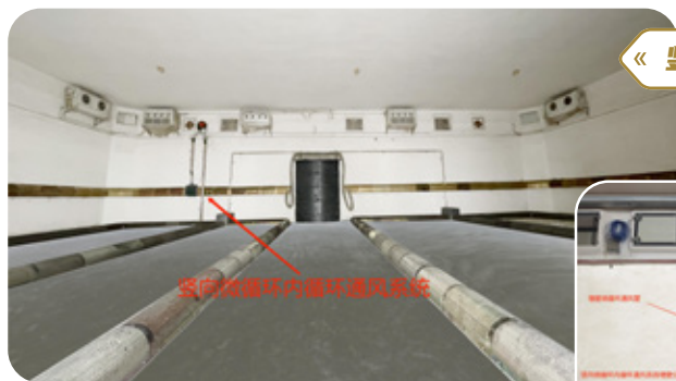
《 2 竖向微循环内循环通风系统局部 》
