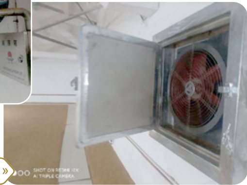
5 « 平房仓底部通风口及环流风机 »
