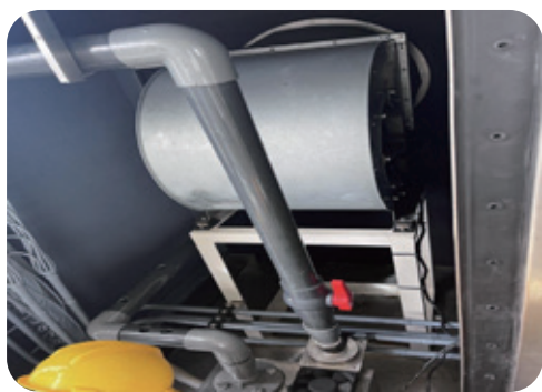
2 蒸发器及送风风机腔体 »
