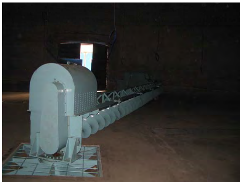
新产品-履带清仓机-仓内安装完成
