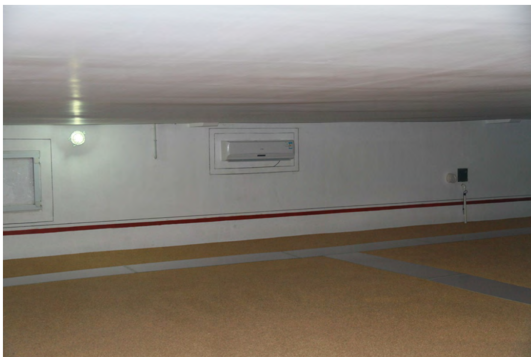
仓内吊顶、安装空调及表面粗壳压盖，春、夏季阻隔外热，控制表层粮温
