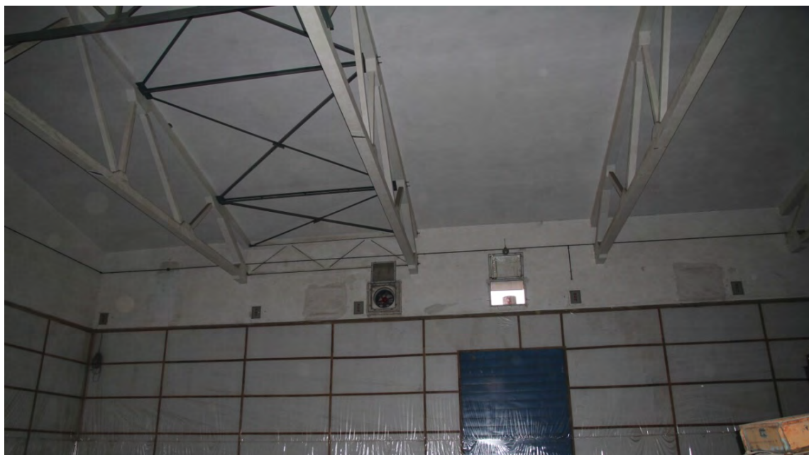
墙体隔热改造，春、夏季延缓粮温上升
