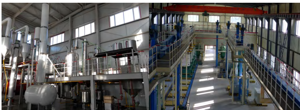
山西宝山 100 t/d 亚麻籽加工项目现场二
