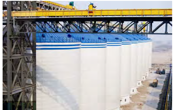
图 2. 京粮集团（天津临港开发区） 油脂加工 9 万 t 仓储项目
