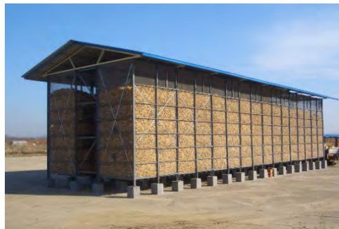
安装自然通风管道的粮仓
