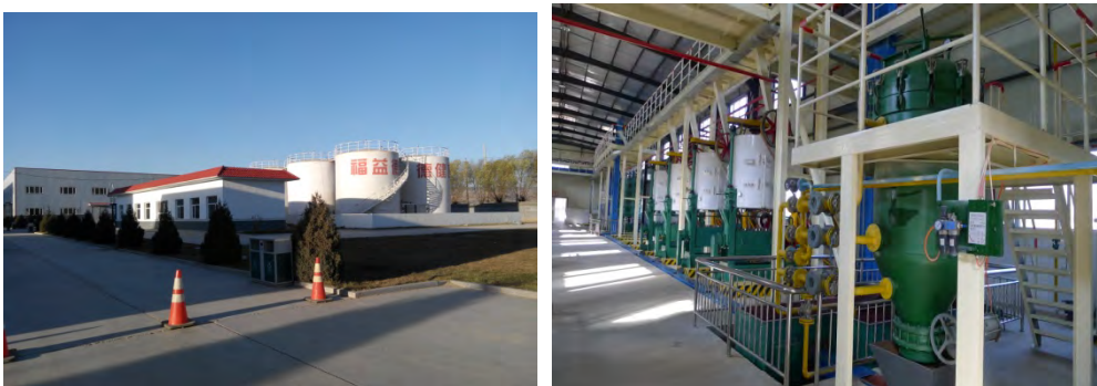
山西宝山 100 t/d 亚麻籽加工项目现场一
