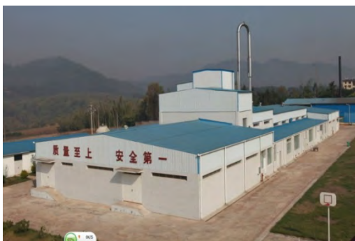
云南普洱永吉生物有限公司生产车间
