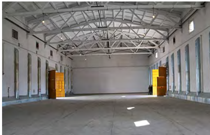
图1 平房仓横向通风应用实景
